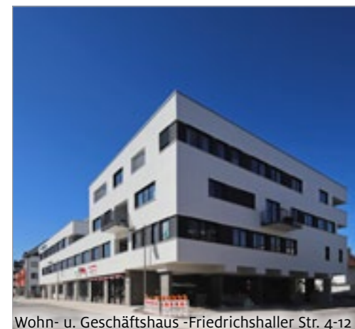
Wohn- u. Geschäftshaus -Friedrichshaller Str. 4-12
